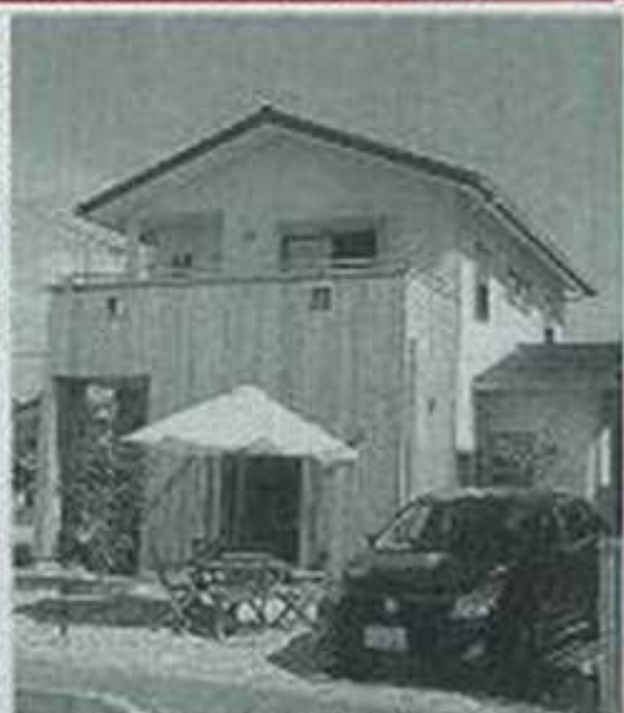
築30年の住宅の基礎や柱を再利用し、改装されたギャラリー——近江八幡市旭上町で
